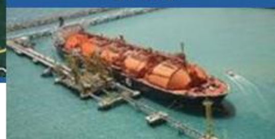
Terminal de regaseificação de GNL
